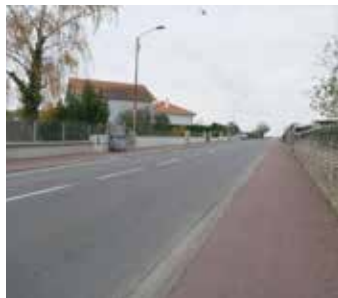
Aménagement de l'entrée de ville route de Neuville
