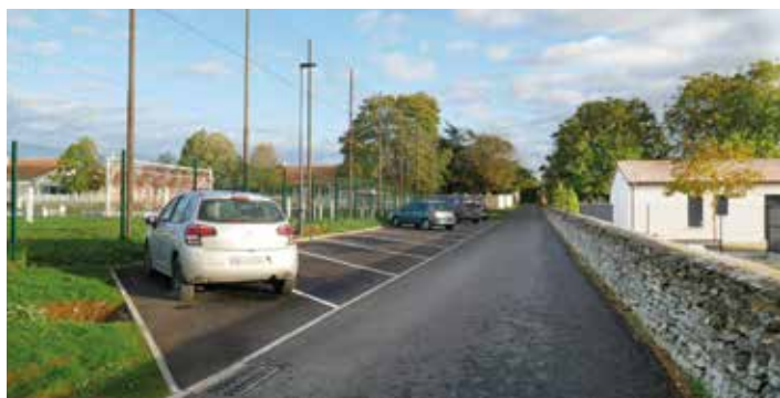
Confection de places de stationnement et réfection de la bande de roulement Allée Jean Claude METAIS
